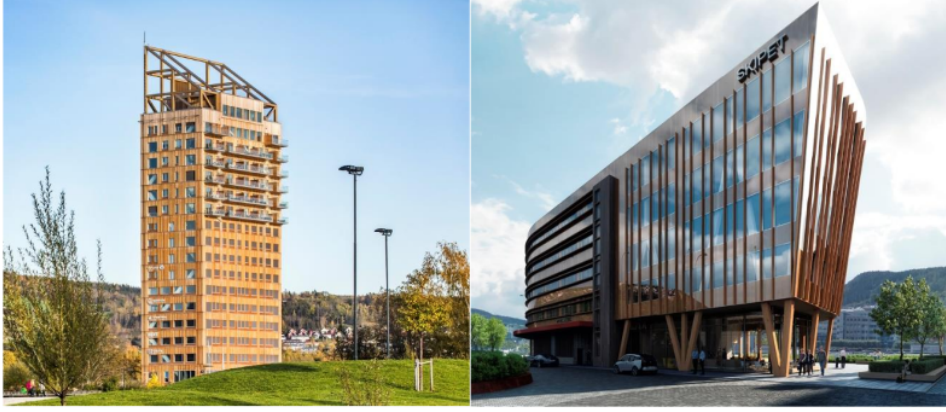
Şekil 3: Norveç'te CLT ile yapılan yapı örnekleri; Mjøstårnet – Brumunddal (ArchDaily, 2021) ve Skipet Ofis– Bergen (Wood In Construction, 2021)
